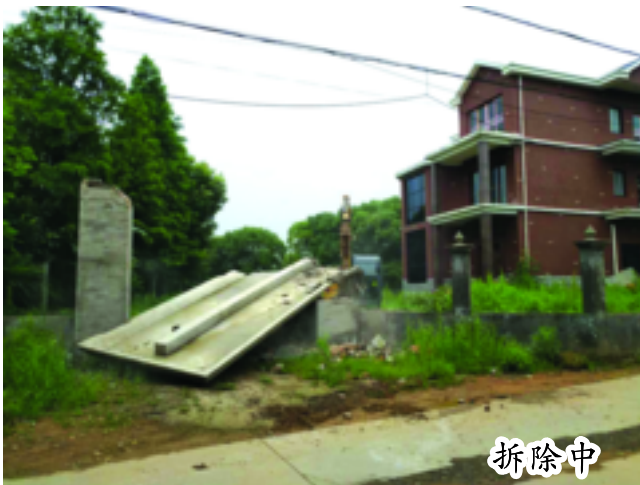
詹家镇山后村老党员栗禹主动请示带头拆除自家一户多宅面积 160㎡,围墙 400㎡。
