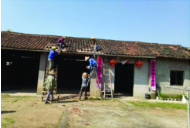
陈村党员潘寿增带头拆除 80㎡的一户多宅。
