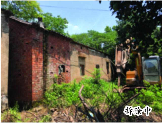
模环乡刘家村老党员韩伟东 6 月 26 日上午带头拆除自家 130㎡的一户多宅。
