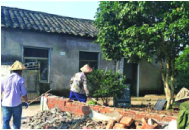
雅村村老党员方培根,6 月 26 日自拆围墙 450㎡。
