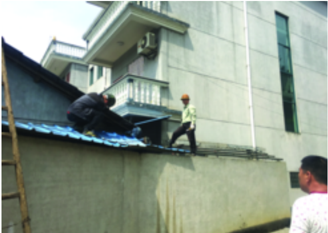
6 月 21 日,社阳村党员张卸根带头拆除架在围墙上的蓝色屋顶。
