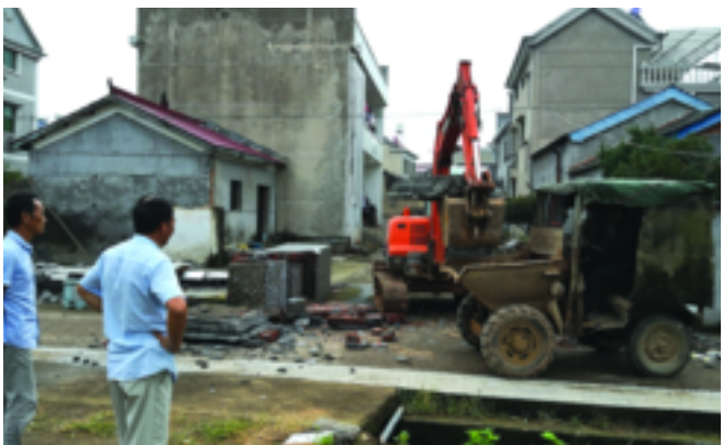
文林村委缪梅贞拆除围墙共 160㎡。
