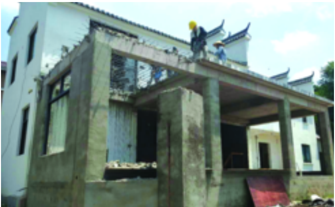
马报桥村党员程秋生自拆违建 60㎡。
