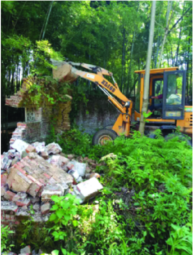
6 月 26 日,龙洲街道半月村无职党员王柏清户自请挖掘机拆除 200㎡的围墙。
